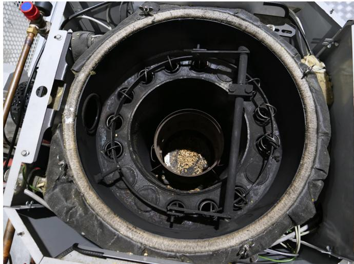
**Figure 23 :** Vider le cendrier de ses cendres est une opération à réaliser aussi souvent que nécessaire selon la fréquence d'usage et le type de combustible.
