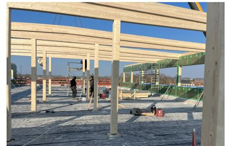
Structure et murs ossature bois de la surélévation
