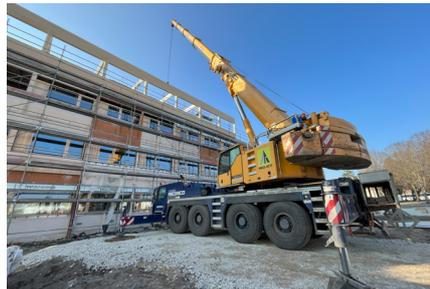
Pose de la structure de bois de la surélévation
