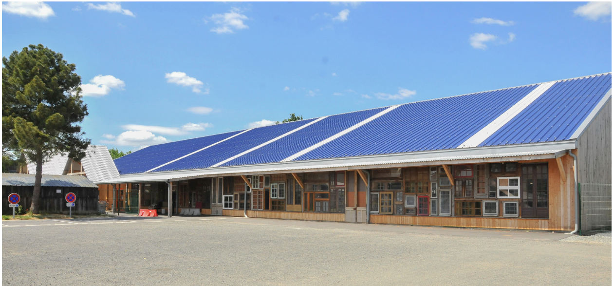
La même façade en fin de chantier Copyright : Terrien architectes
