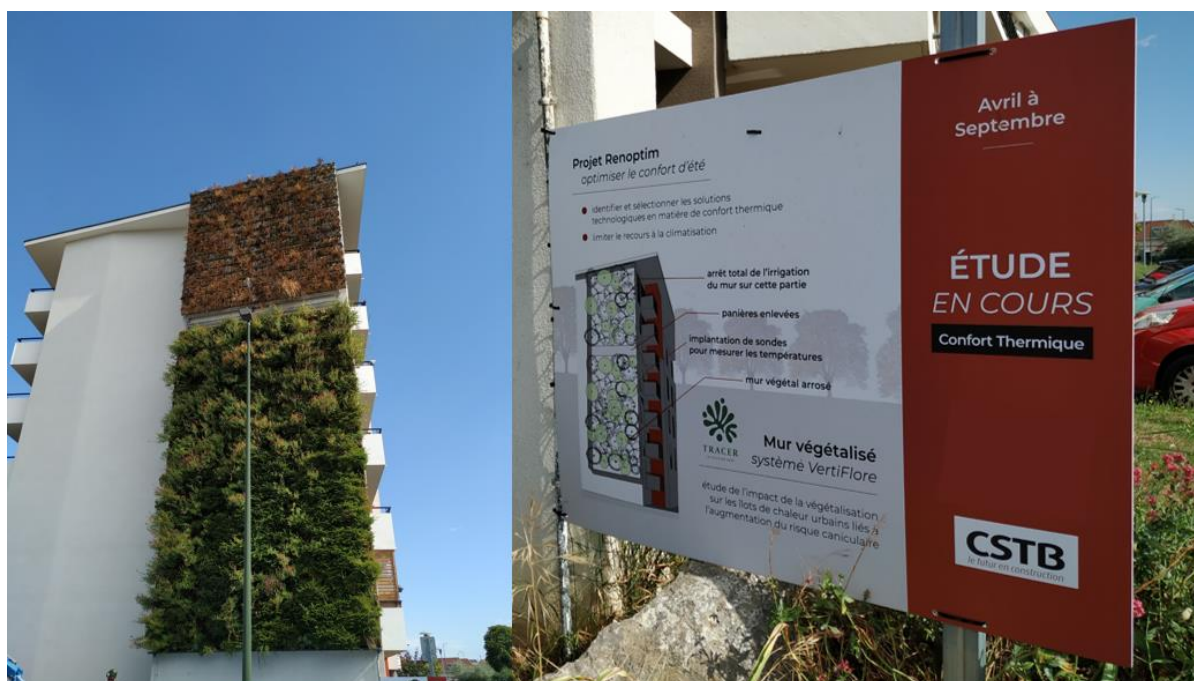
Figure 3 - Démonstrateur d'un mur végétalisé à bardage rapporté (entreprise TRACER). En haut le logement témoin (non arrosé), en bas le logement avec la solution (arrosé).
