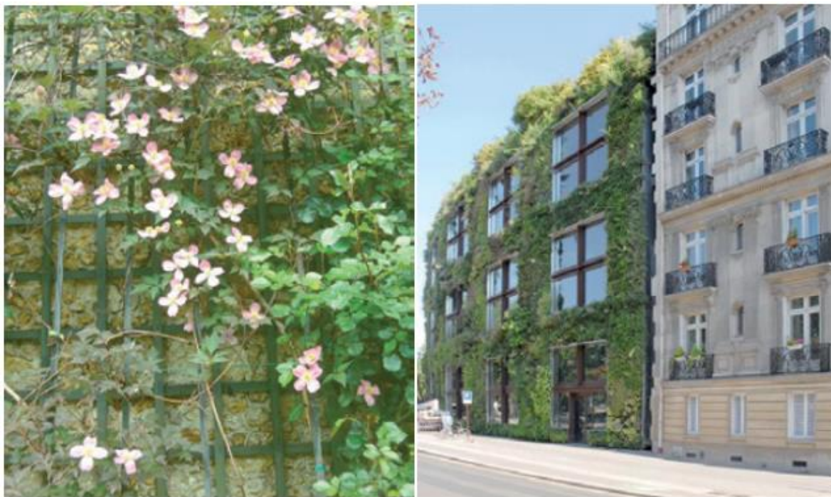
Figure 1 - À gauche, clématite (plante grimpante sur son support en treillis). À droite, mur végétalisé modulaire. (source : Guide pratique « Végétalisation des murs » - CSTB 2015)
