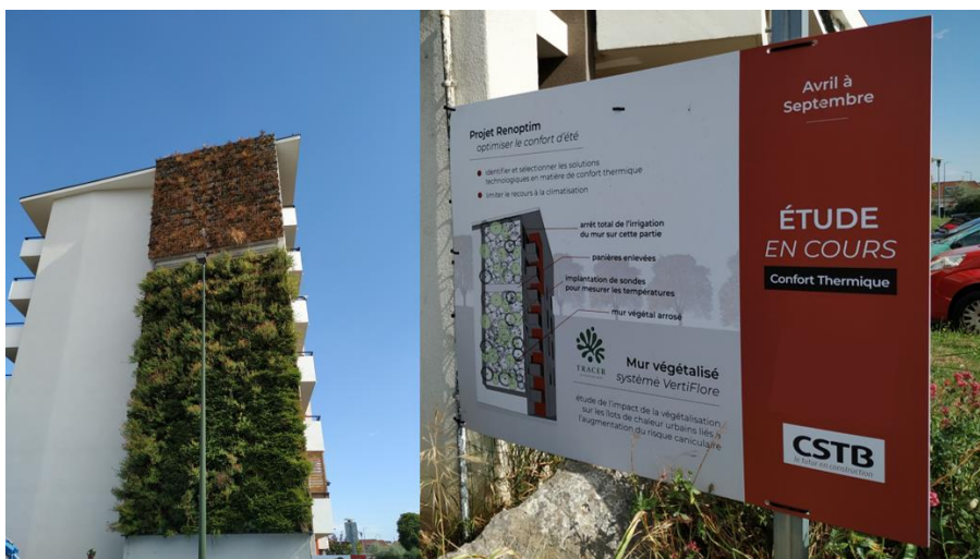
Figure 3 - Démonstrateur d'un mur végétalisé à bardage rapporté (entreprise TRACER). En haut le logement témoin (non arrosé), en bas le logement avec la solution (arrosé).
