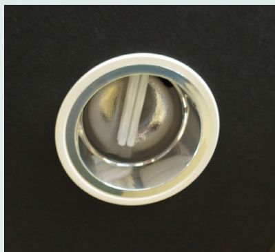
Luminaire équipé d'une lampe fluocompacte. Source : Cerema
