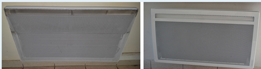
Ancien convecteur électrique (à gauche) remplacé par un convecteur électrique plus récent (à droite) piloté par une centrale de programmation multizones. Source : Cerema
