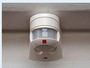
Détecteur de mouvement dans une circulation Source : Cerema
