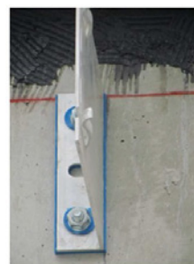
Illustration 7 - La mise en place de rupteurs de ponts thermiques au niveau des accroches de l'isolation thermique par l'extérieur limite les déperditions.
