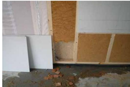
Humidité nécessitant un démontage du frein vapeur et un remplacement des matériaux
