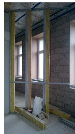
Mise en œuvre du Chanvre par l'intérieur - rehafutur
