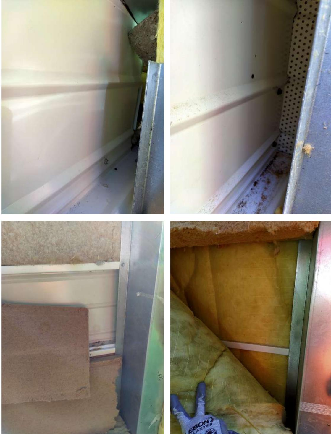
PHOTO 20\_D Isolants, fixations, écarteurs et plateaux en parfait état
