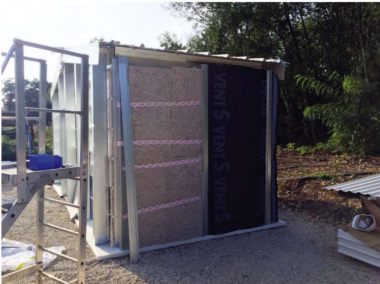
PHOTO 17\_C Vue du pignon avec partie équipée du pare-pluie et partie sans pare-pluie
