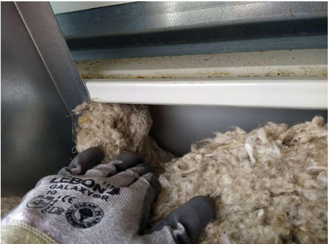
PHOTO 14\_D Vue des plateaux et des isolants
