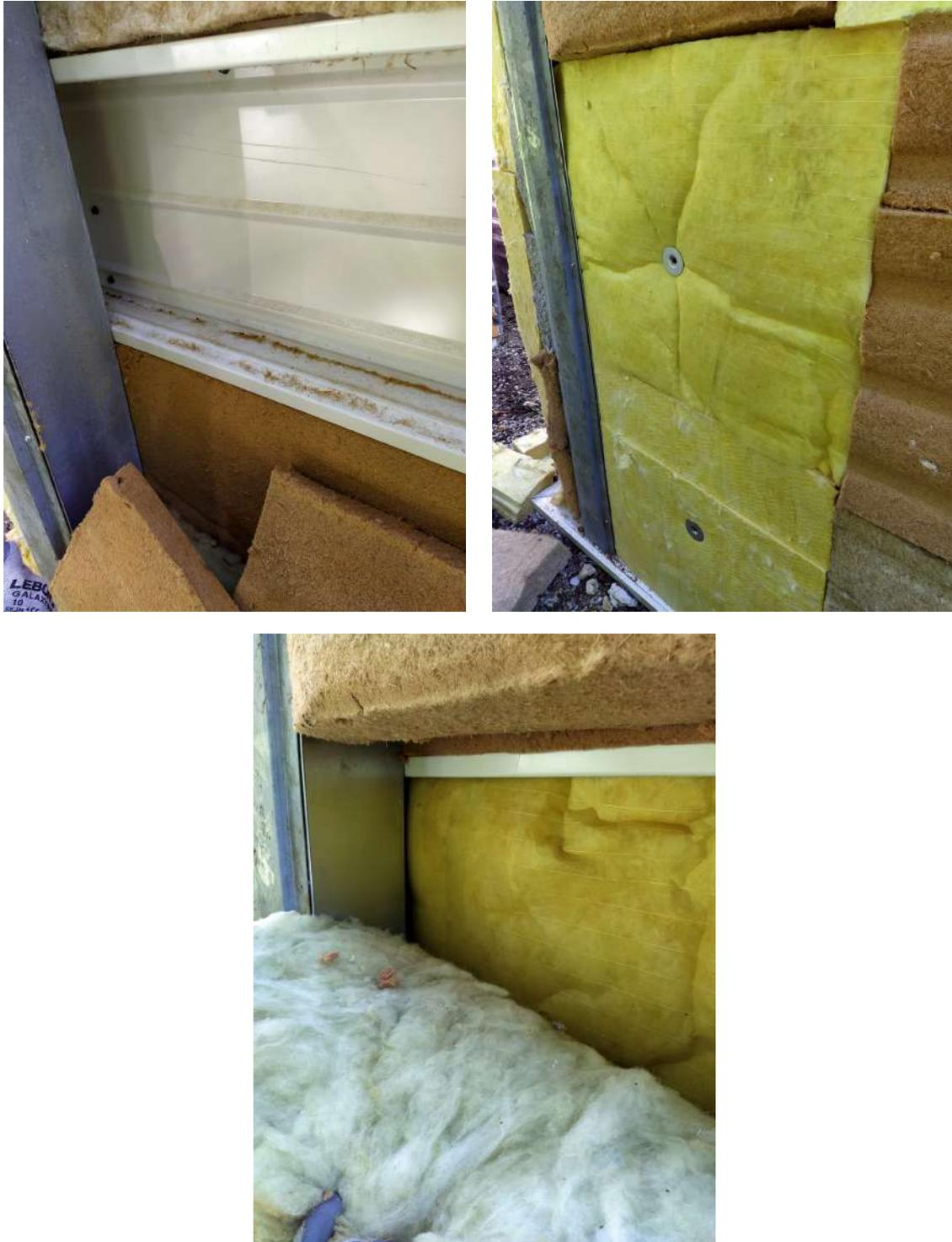
PHOTO 24\_D Isolant et plateaux en parfait état
