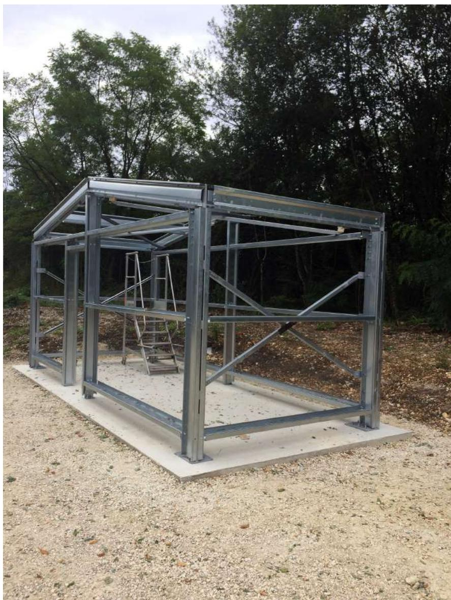
PHOTOS 1-C Vue de la structure porteuse en éléments mines (portiques, lisses pannes) du démonstrateur
