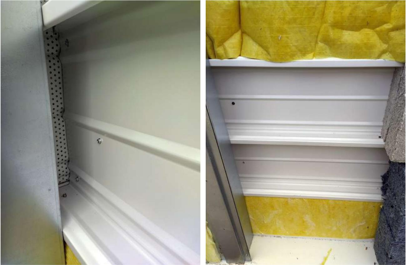
PHOTO 6\_D Vue des plateaux en parfait état - Vue des isolants et plateaux en parfait état
