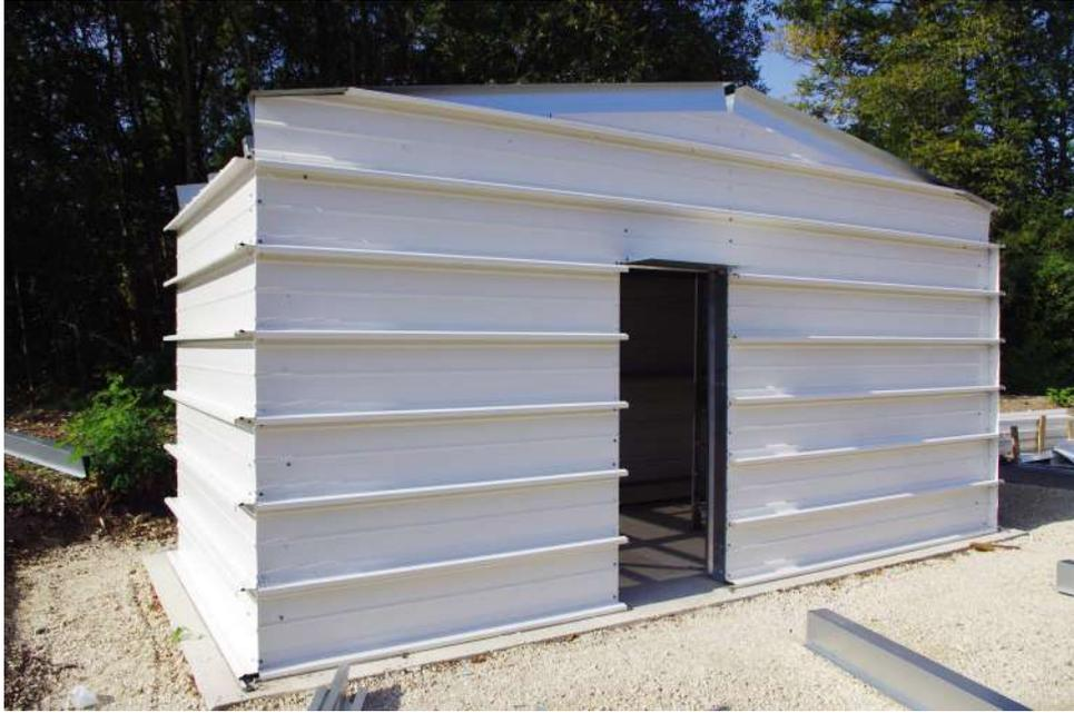
PHOTO 9\_C Vue des plateaux de bardage constituant la peau intérieure
