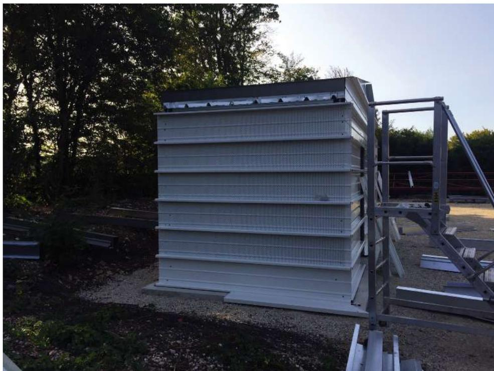
**PHOTOS 4-C** Vue de la peau intérieure du pignon du démonstrateur réalisée en plateaux pleins
