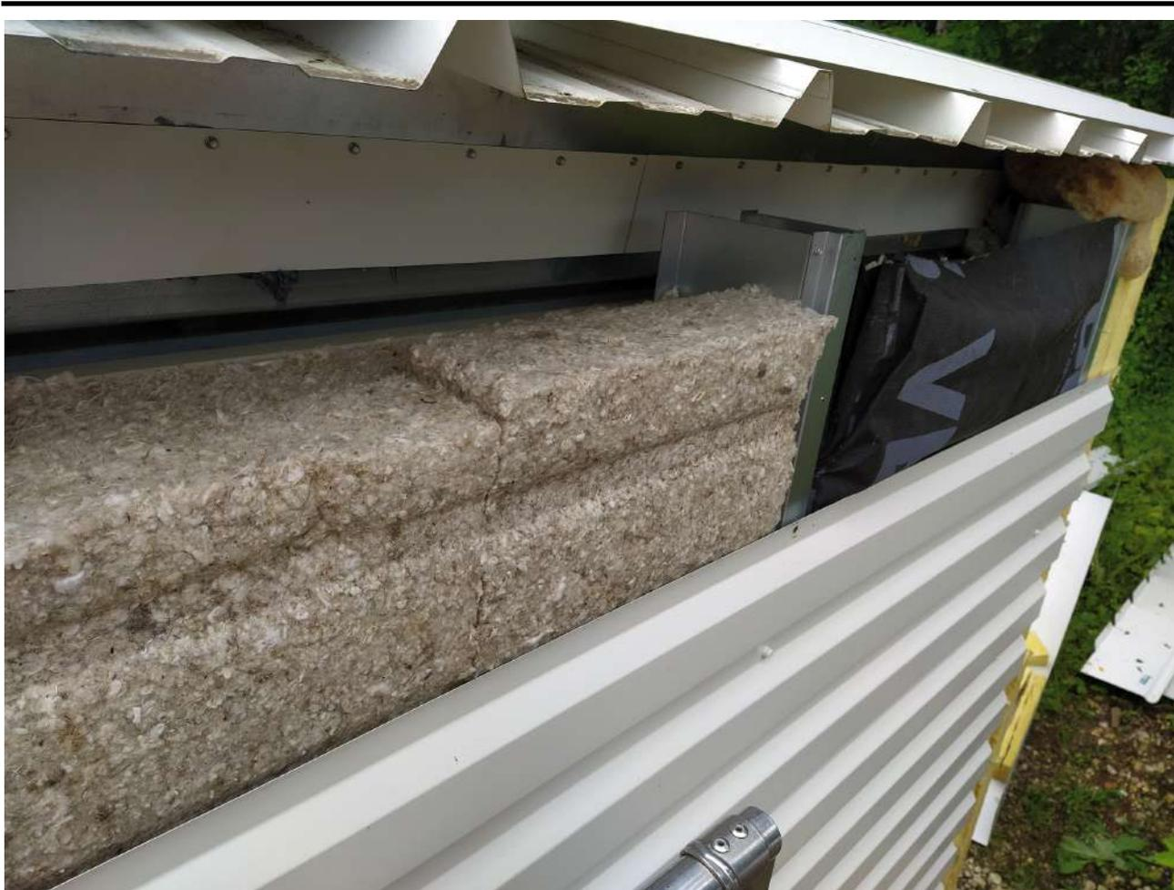
PHOTO 15\_D Vue du bardage double peau en pignon (isolant mixte)
