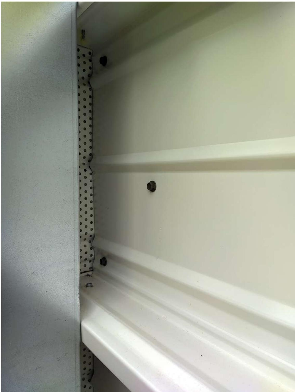
PHOTO 13\_D Vue des plateaux écarteurs et fixations en parfait état
