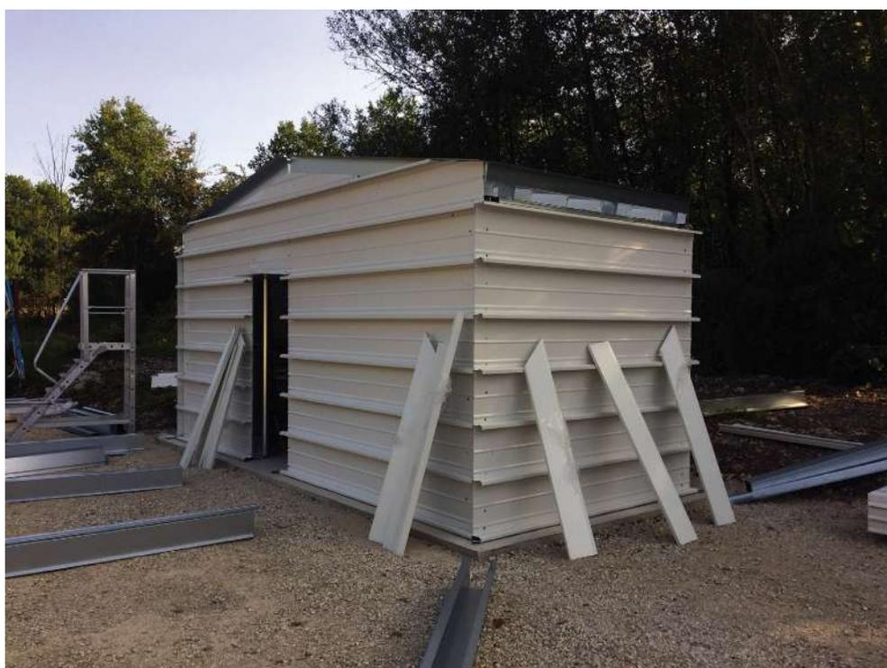
**PHOTOS 5-C** Vue de la face avant et d'un pignon équipé de la peau intérieure du démonstrateur (plateaux pleins)
