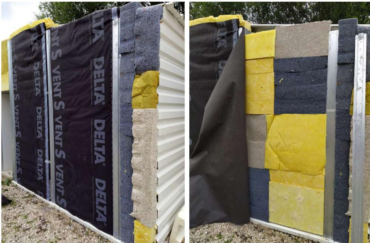
PHOTO 3\_D Vue de l'angle (pare-pluie, écarteurs oméga, isolants)
