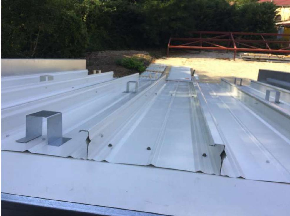
FIG 8\_C Rampant avec plateaux pleins et entretoises supports de fausses pannes
