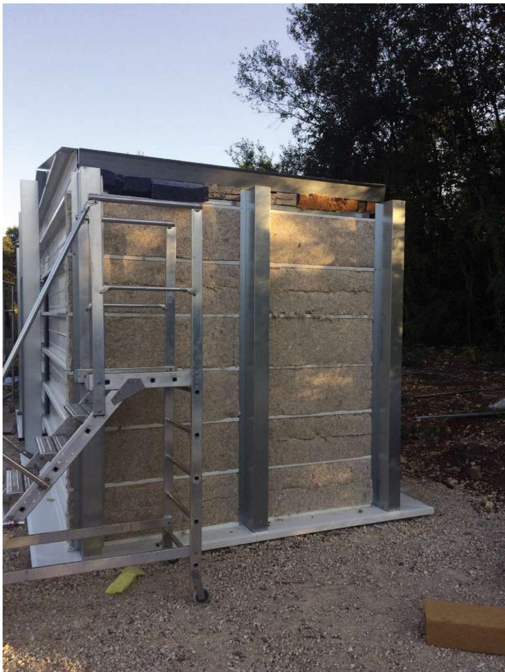
PHOTO 12\_C Vue du pignon en cours de montage avec isolants en fond de plateaux
