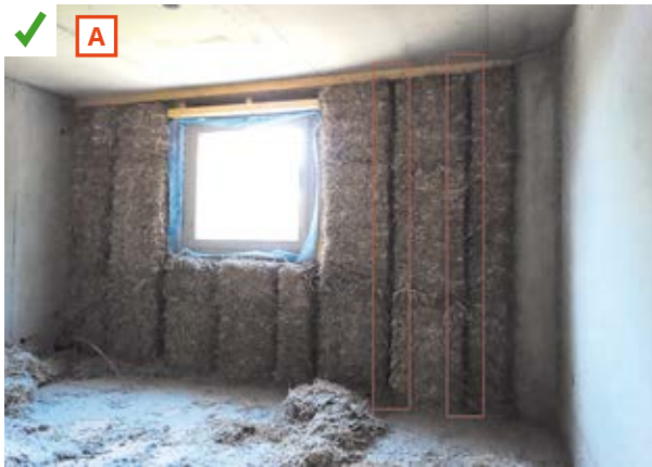
Diminution de la profondeur des montants. ©AQC-2015
