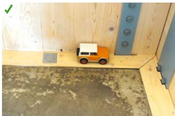
Intégration des installations électriques à la périphérie du plancher. ©AQC-2015
