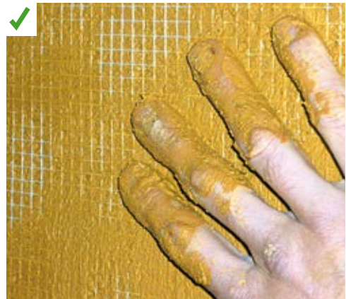
Mise en œuvre du support d'enduit terre avec toile de jute. ©Argilus
