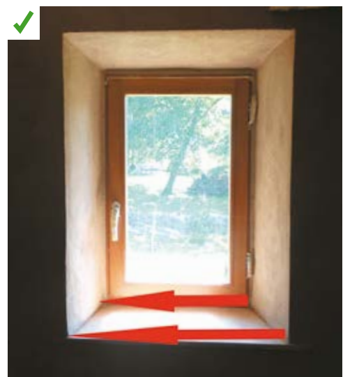
Travail d'ébrasement incliné lors d'une rénovation thermique intérieure. ©AQC-2015
