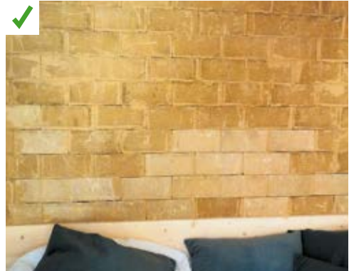
Paroi en brique de terre crue (avant finition avec un enduit terre) dans une construction en bois. ©AQC-2015
