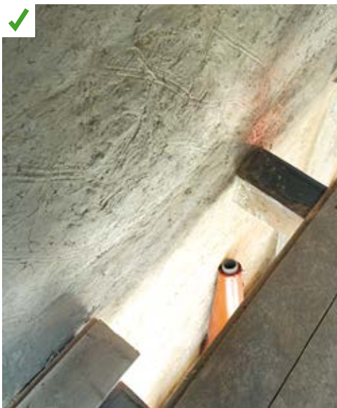
Découpe périphérique du plancher pour permettre le passage de l'isolant. ©AQC-2015
