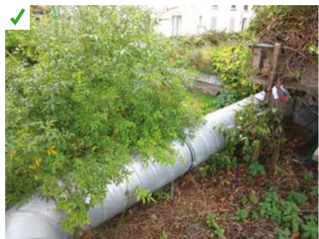
Pour installer des plantes sensibles au gel comme le jasmin, le paysagiste a tiré profit des calories libérées par ce conduit d'extraction d'air chaud. ©AQC
