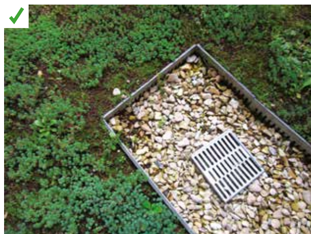
Bande stérile aménagée tout autour de l'avaloir d'eaux pluviales. ©AQC
