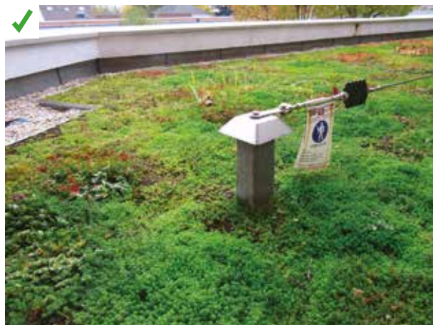
Point de départ d'une ligne de vie. Cet équipement est nécessaire pour sécuriser les interventions de courte durée. ©AQC
