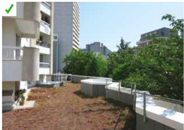
Lors des travaux de rénovation, la toiture-terrace du R+1 a été végétalisée. Un accès indépendant sécurisé avec une échelle à crinoline a été aménagé. Il n'est plus nécessaire d'emprunter les logements pour accéder à la terrasse. ©AQC
