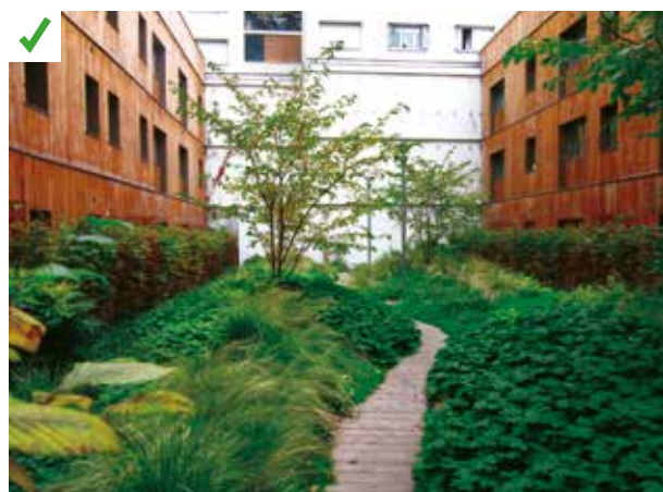
La dalle béton couvrant le parking a été isolée par l'extérieur et végétalisée lors de la réhabilitation. La surcharge admissible autorisait 15 cm de substrat. Le paysagiste a créé un relief artificiel au moyen d'une sous-couche en matériaux légers. Des grands sujets en pot ont été positionnés au droit des poteaux. ©AQC
