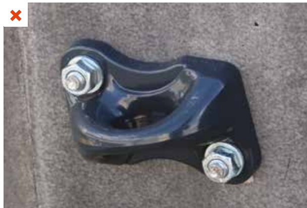
L'installation des points d'ancrage n'a pas été inspectée par un organisme notifié. En l'absence de certification l'entretien de la toiture n'est donc pas possible. ©AQC
