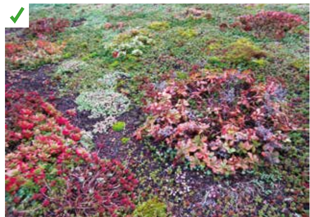
Les variations d'épaisseurs du substrat, de 8 à 15 centimètres selon les zones, permettent une implantation de végétaux plus variés. Le couvert végétal développe un meilleur enracinement. Les plantes se portent bien, même en été, et le substrat n'est pas érodé. ©AQC
