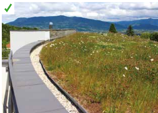
La palette végétale a été composée à partir d'essences locales. L'adaptation du couvert végétal à son environnement facilite sa gestion et rend très faible le besoin d'entretien. ©AQC
