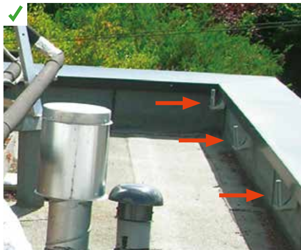
Des potelets servant à accueillir un garde-corps amovible sont fixés le long du retour d'acrotère. ©AQC
