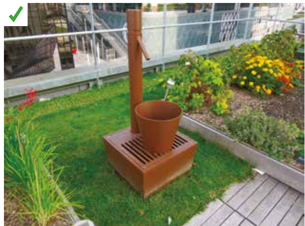
L'édicule technique qui logeait la machinerie de l'ancien ascenseur a permis d'installer une cuve souple de récupération d'eaux pluviales de 3 mètres cubes. Ce point d'eau est alimenté directement sans surpresseur via un circuit court de tuyauterie. ©AQC
