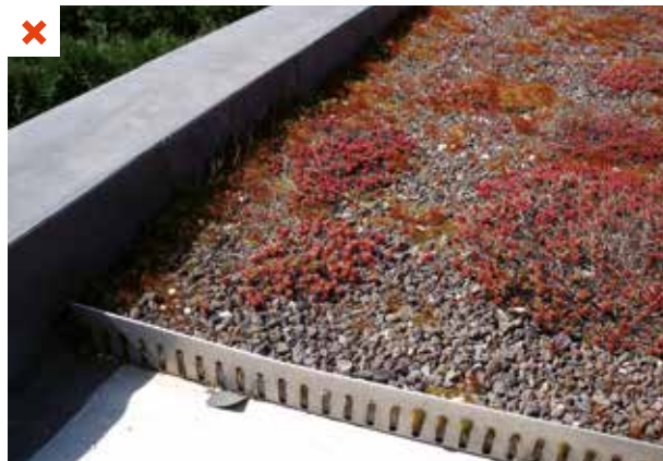
Substrat composé presque uniquement de granulats de pouzzolane. ©AQC
