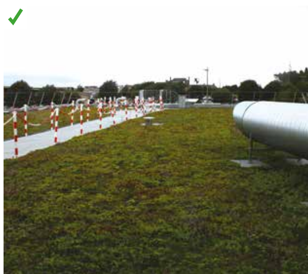
À la fin de la phase travaux, un balisage a été mis en place pour limiter l'accès à la surface végétalisée. ©AQC
