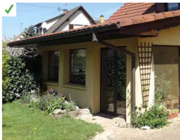
Protection solaire correctement dimensionnée. ©AQC
