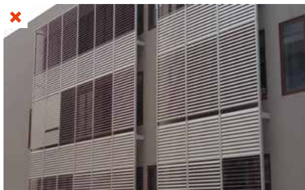
Tous les brise-soleil ne sont pas utilisés par les occupants pendant une journée ensoleillée d'été. ©AQC
