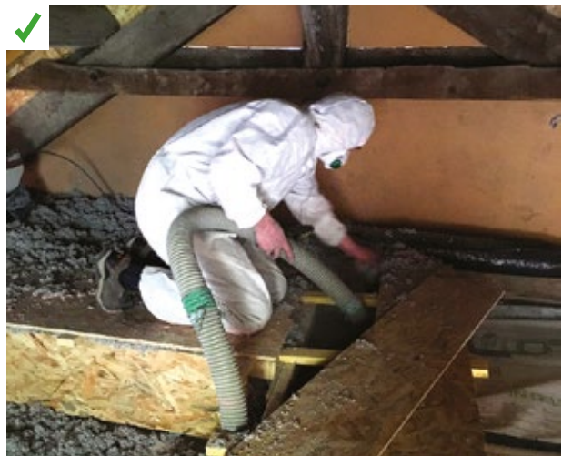
Mise en place d'un cheminement technique pour accéder au groupe de ventilation. L'intérieur du caisson est isolé et une lame d'air est maintenue entre l'isolant et le haut du coffrage. ©AQC
