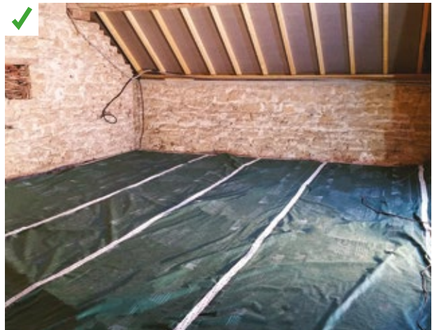
Le traitement de l'étanchéité à l'air a été effectué sur le plancher, avant de recevoir l'isolant. La membrane doit être prévue à cet effet. ©AQC
