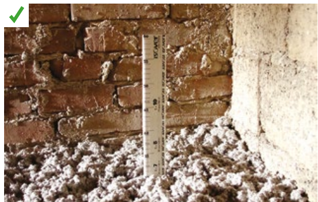
Repérage ponctuel de la hauteur à souffler à l'aide d'une règle graduée. ©AQC
