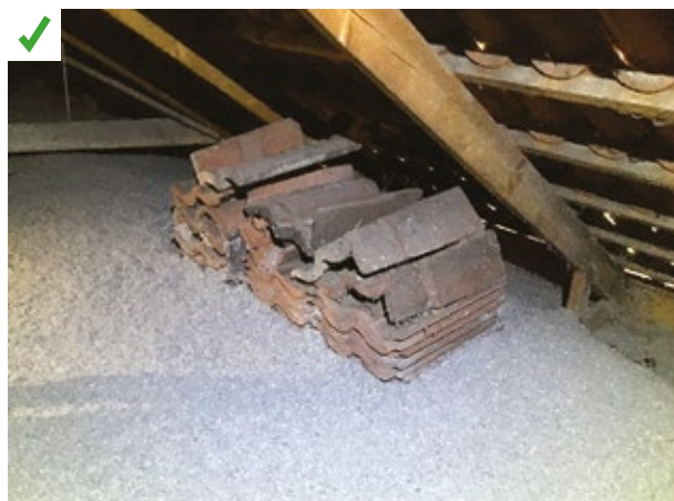
Ces tuiles ne reposent pas directement sur l'isolant. Une plateforme technique isolée a été aménagée pour les stocker. ©AQC
