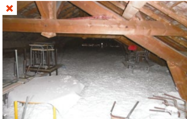
Les objets stockés dans le comble ont été recouverts d'isolant lors du soufflage. ©AQC
