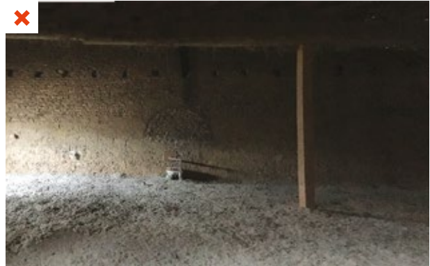
Des gaines et des boîtes de dérivation sécurisées se trouvent sous les 40 centimètres d'isolant soufflé. Il est impossible de les repérer en l'état. ©AQC
