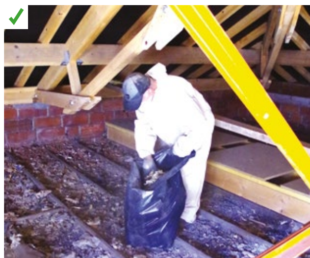
Le comble est vidé de tous les objets encombrants. Les gravats entre les solives seront évacués. Avant le soufflage de l'isolant, le support sera nettoyé et les poussières aspirées. ©AQC
