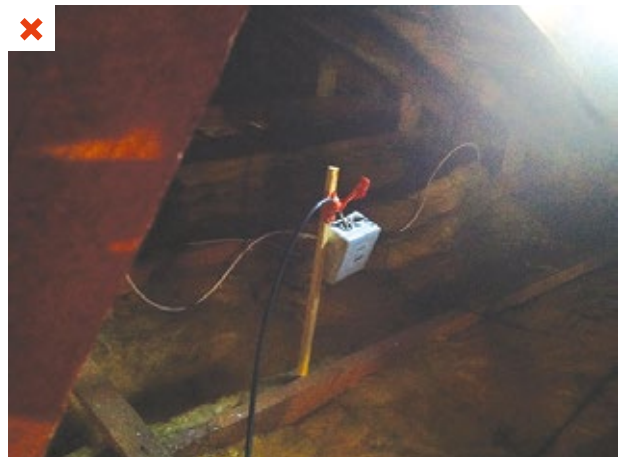
Le support rigide ajouté n'est pas dimensionné en conséquence pour supporter le boîtier de façon durable. ©AQC
