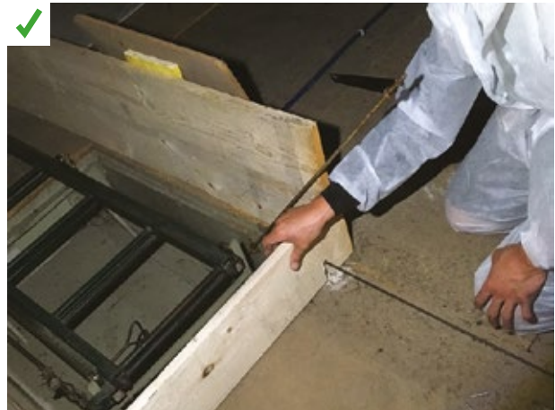
Mise en place d'un coffrage en périphérie de la trappe d'accès pour contenir l'isolant soufflé. ©AQC
