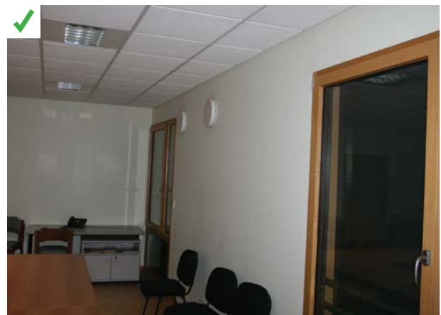
Ventilation double flux décentralisée implantée en hauteur dans la pièce. Le flux d'air est parallèle au mur de support. La diffusion de l'air neuf est optimisée par effet coanda, avec une vitesse de soufflage suffisante pour assurer un balayage complet de la pièce et sans gêne perceptible pour les usagers.
