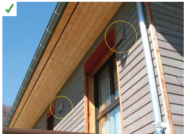
Capot de bouche inox posé sur un bardage à clin grisé en partie haute sous l'avancée de toit. L'intégration des capots est discrète et acceptée par la maîtrise d'ouvrage. ©AQC
