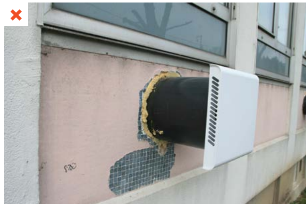
Fourreau d'un module de ventilation traversant un mur béton avant la pose de l'isolation extérieure. Le diamètre de carottage est trop important. Le joint en mousse expansive seul pour assurer l'étanchéité à l'air n'est pas une solution adaptée. ©AQC
