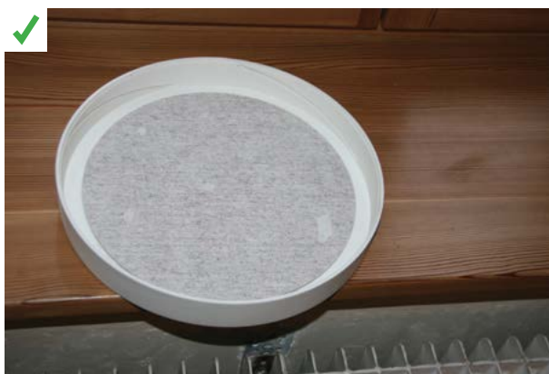
Mise en place d'un filtre acoustique à l'intérieur du capot de la bouche du module push-pull. Fourni par le fabricant, il permet une atténuation du bruit extérieur de 2dBA sans modifier les débits d'air. ©AQC
