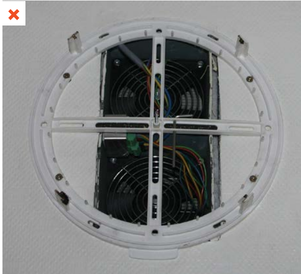
L'entretien des moteurs et des échangeurs-accumulateurs impose le dévissage de 4 vis par module. ©AQC
