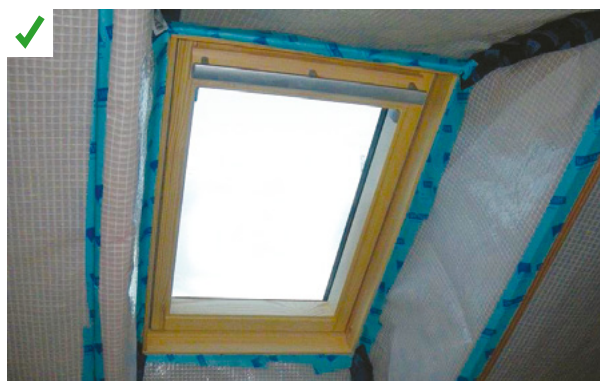
L'interface entre la fenêtre de toit et les rampants est isolée et étanche à l'air. ©AQC
