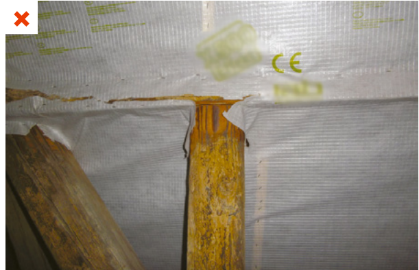
La membrane est déchirée au droit des éléments de charpente la traversant. Elle n'est fixée que par des agrafes. Aucune reprise n'a été effectuée. ©AQC
