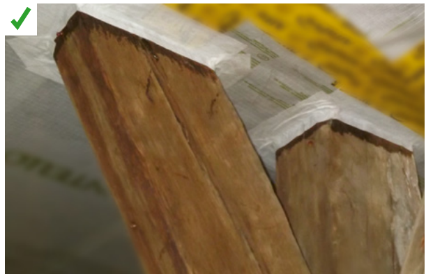
Un primaire d'accrochage a été appliqué sur les pièces de bois pour une meilleure adhérence de l'adhésif. ©AQC
