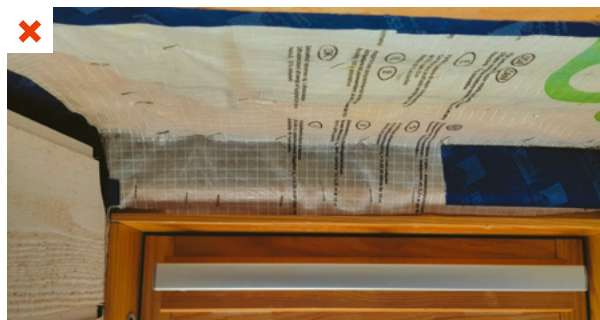
La membrane est fixée sur le dormant de la menuiserie avec des agrafes assurant une tenue mécanique. En revanche, l'étanchéité à l'air n'est assurée ni par un adhésif ni par un mastic. ©AQC
