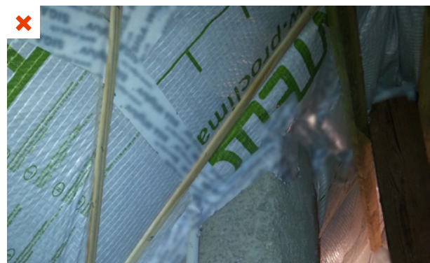
L'isolation et la membrane d'étanchéité à l'air sont en contact direct avec le conduit de cheminée maçonné. ©AQC
