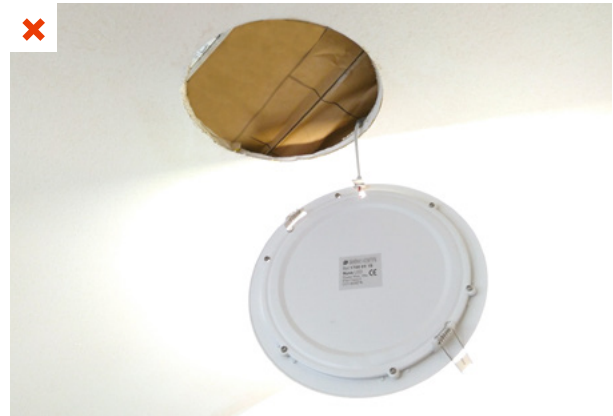
L'isolant, en panneaux revêtus d'un surfaçage Kraft et classé inflammable, est en contact direct avec le spot encastré. ©AQC
