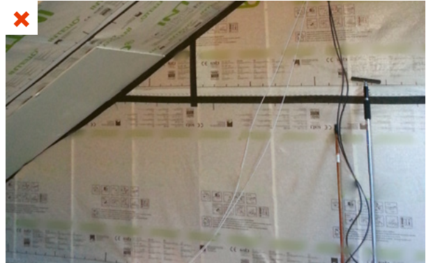
La membrane d'étanchéité à l'air est collée sur les fourrures métalliques à l'aide d'un adhésif double face. La plaque de plâtre, vissée également sur les fourrures métalliques, se retrouve en contact direct avec la membrane. ©AQC
