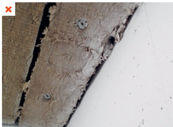
Isolation à l'aide de panneaux semi-rigides rapportés sous dalle. Isolation non jointive suite à une découpe imprécise d'un panneau. ©AQC
