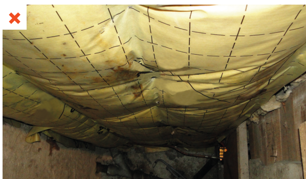
La membrane pare-vapeur est positionnée du côté non chauffé de la paroi (isolation de planchers bois sur cave par rouleaux de laine minérale).
