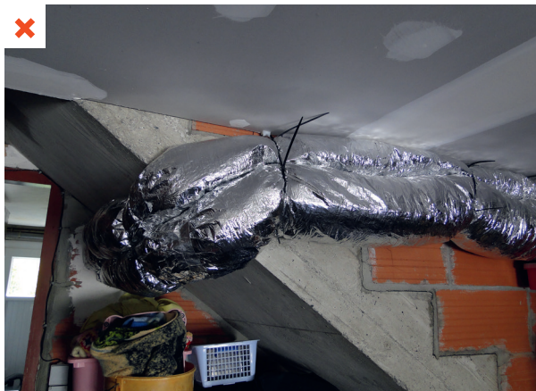
L'escalier intérieur de la maison traversant le garage n'a pas été pris en compte lors de l'isolation du plafond du garage. ©AQC
