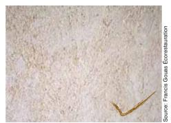
L'enduit brossé fait ressortir la diversité des grains de sable. Le brossage permet de vieillir prématurément l'enduit.
