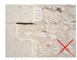
Ici, l'enduit couvrait initialement moellons. Le rejointoiement n'est donc pas adapté puisqu'on retrouve les traces de piquage et la surépaisseur des pierres de taille de la chaîne d'angle
