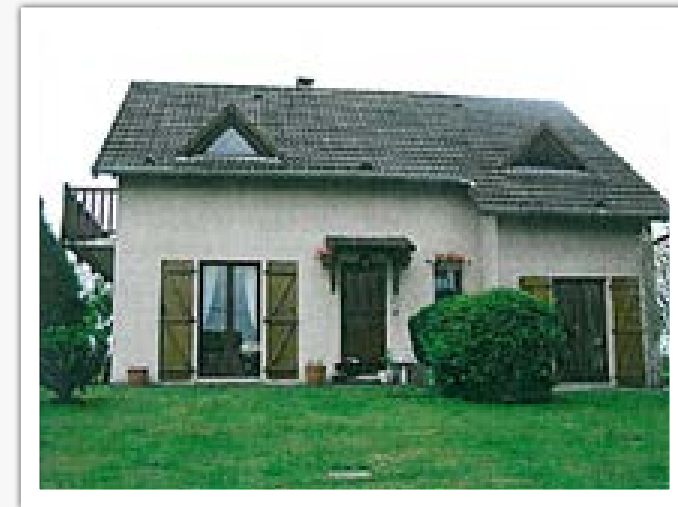
Menoncourt, Territoire de Belfort, Source Efflogis
