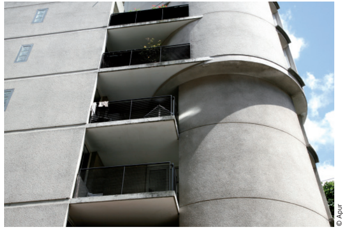
Rue Louise Weiss, 13 e arrondissement, 1990, E. Girard architecte. Bâtiment des années 90 isolé par l'intérieur.
