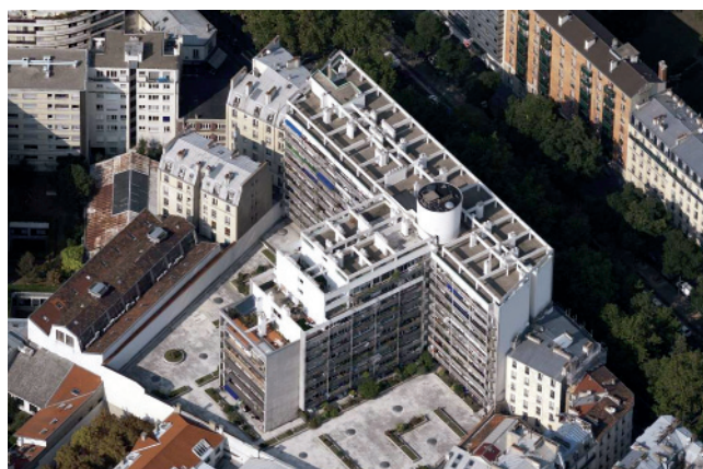
Boulevard de la Villette, 19 e arrondissement. Bâtiment de logements inséré dans un tissu existant suivant une disposition en « T ».
