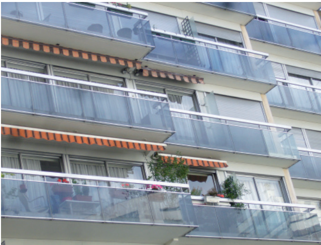
Rue d'Hautpoul, 19 e arrondissement. L'isolation extérieure du bâtiment suppose le manchonnage des balcons.
