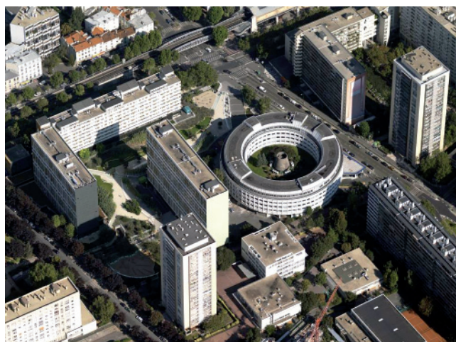
Boulevard Vincent Auriol, 13 e arrondissement. Îlots de type « plan masse libre », immeuble de logement collectif.
