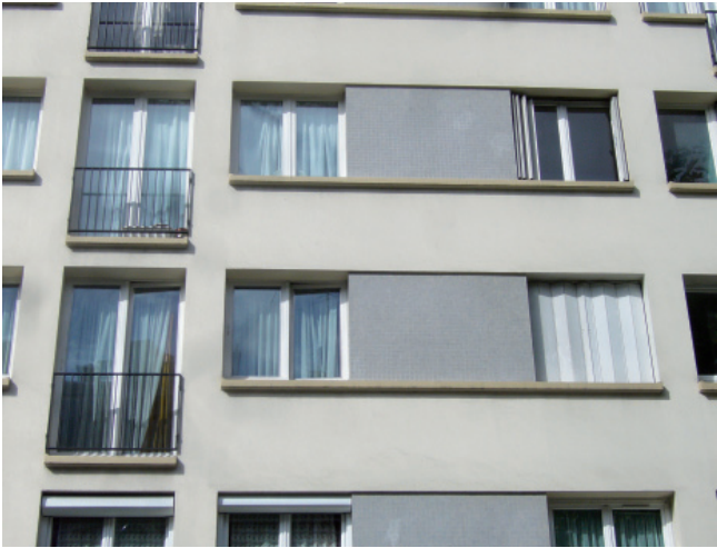
Rue Botzaris, 19 e arrondissement. Bâtiment pour lequel une reprise de la façade peut être envisagée pour en améliorer les performances thermiques : isolation par l'extérieur, ou double mur, ou double peau, etc.
