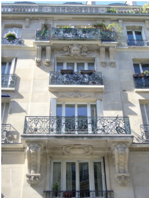
Façade sur rue d'un bâtiment post-haussmannien ne se prêtant pas à l'isolation par l'extérieure
