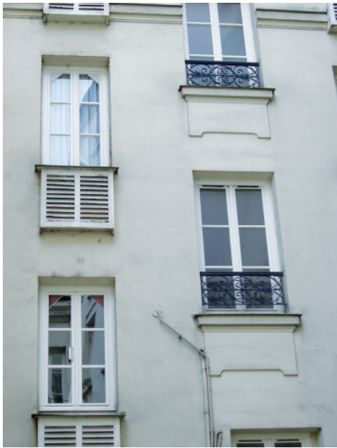
Façade sur cour d'un immeuble haussmannien pouvant se prêter à une isolation par l'extérieure (les garde-mangers devront être condamnés)
