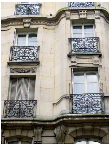
Immeuble de type post-haussmannien
