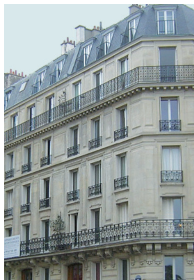
Immeuble de type haussmannien
