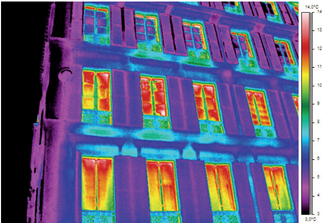
Rue Castellane, 8 e arrondissement. Fuites thermiques occasionnées par les vitrages.
