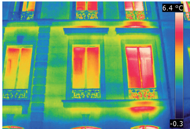
Rue Cambacérés, 8 e arrondissement. Convecteurs placés sous les fenêtres.
