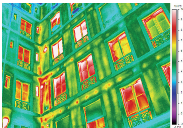
Rue des Haudriettes, 3 e arrondissement. Façade en pans de bois et moellon dont la composition apparaît sur le thermogramme.
