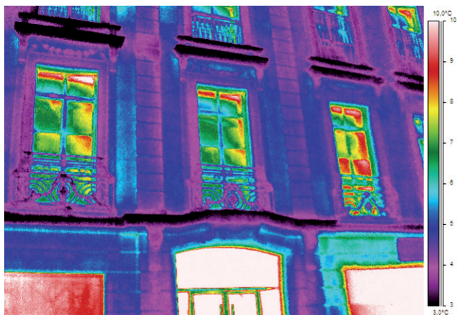
Avenue Friedland, 8 e arrondissement. Absence de ponts thermiques au niveau des planchers.
