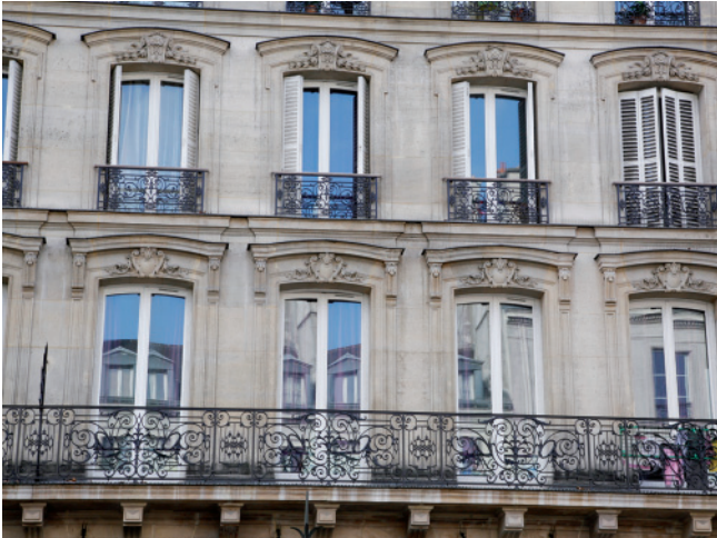
La qualité architecturale de la façade interdit la mise en œuvre d'une ITE
