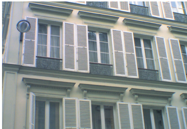
Façade sur rue en maçonneries enduites
