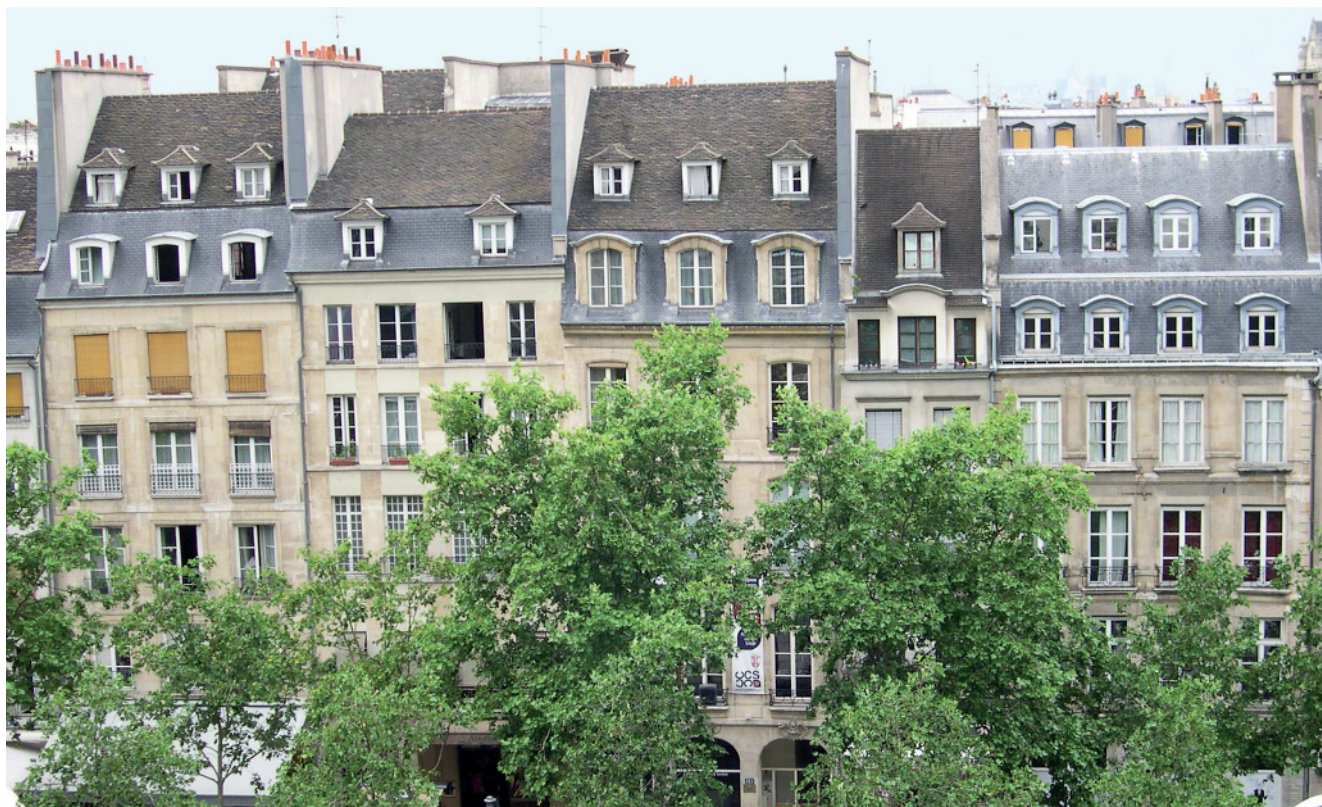
Immeubles construits avant 1800, rue Saint-Martin, 1 er arrondissement.
