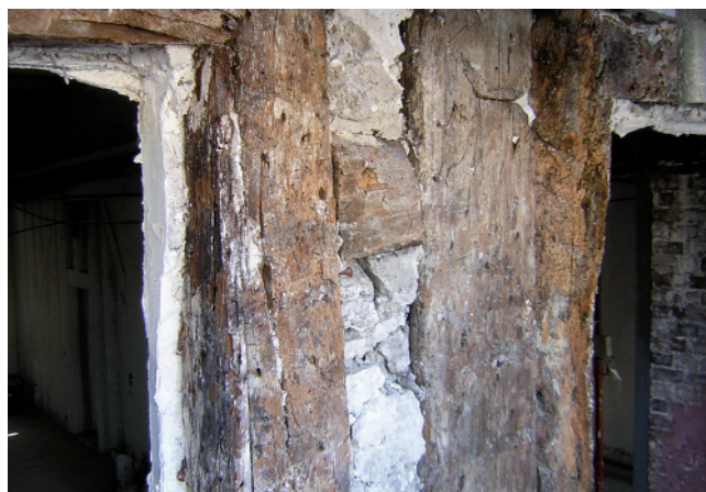
Rue des Innocents, 1 er arrondissement. Bâtiment en cours de réhabilitation : l'enduit a été retiré autour des ouvertures faisant apparaître la composition des murs en pans de bois/moëllon.
