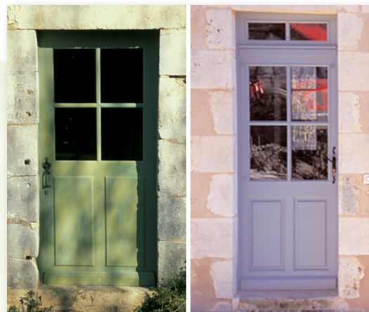
8 Porte en bois pleine ou vitrée en partie haute avec volet amovible. Linteau et jambages en pierre, bois, ou brique.
