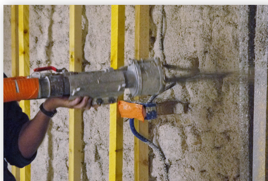
Projection d'un enduit isolant (béton chaux-chanvre).
