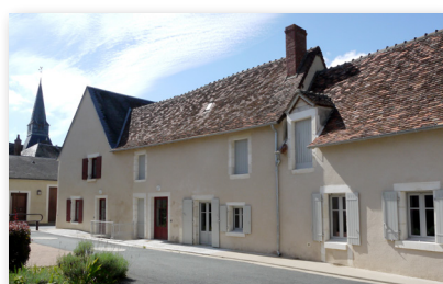
Immeuble Petit-Jean Rivarennès (2013-2015)
