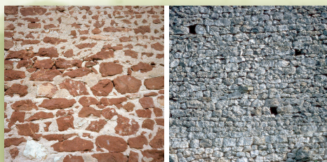
2 En grès rouge, ocre ou noir, ou en calcaire, les murs sont maçonnés à la terre et enduits à la chaux naturelle.
