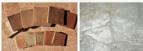
7 Sol sur terre-plein constitué de carreaux de terre cuite posés sur mortier de terre ou de chaux, ou plus rare d'un dallage en pierre.
