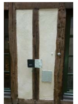
Mesures température de rayonnement réfléchi et d'air (Paris 2016 projet FaHeBA)
