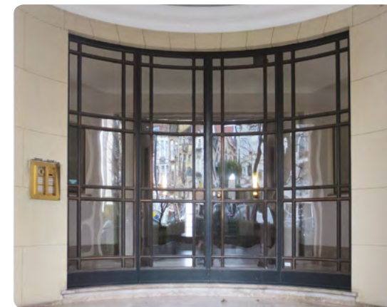
Porte moderniste en acier (1936) Avenue Maurice 31, 1050 Ixelles
