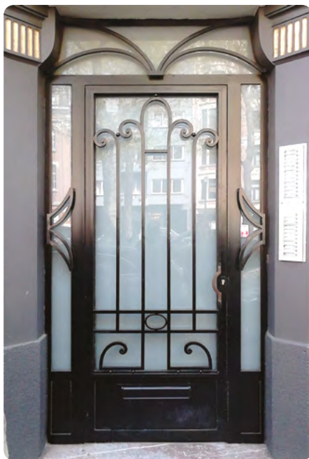
Porte neuve réalisée à l'identique de la porte d'origine (1934). Quai du Commerce 23, 1000 Bruxelles
