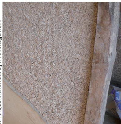
3) Un béton biosourcé picard : « l'isolibois » fabriqué à partir de déchets de bois et de lin, recouvert en partie de l'enduit extérieur « le plafond picard ».
