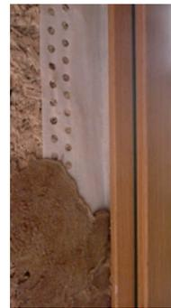
Traitement de l'étanchéité à l'air entre le mur et le dormant à l'aide d'une trame adhésive spéciale préalablement collée au dormant et noyée dans l'enduit de finition
