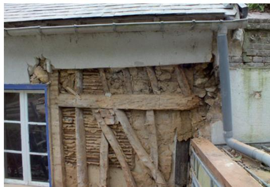
Un petit défaut de gouttière et un mur recouvert d'un enduit au ciment, ont provoqué un pourrissement des bois de structure qui ne pouvaient plus sécher.
