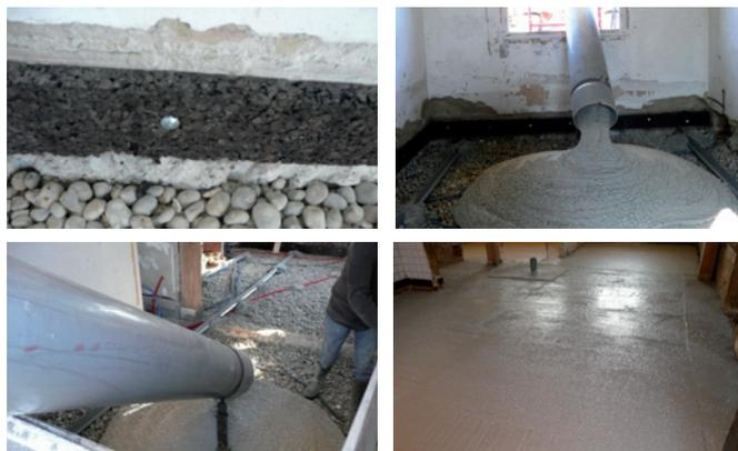
Photographies illustrant la mise en œuvre d'un béton de pierre ponce sur hérisson de cailloux, en réhabilitation, avec bande de désolidarisation isolante en liège en périphérie.
