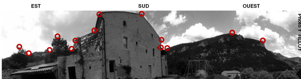
▲ Figure 18 : Relevé des masques depuis l'emplacement prévu pour les capteurs
