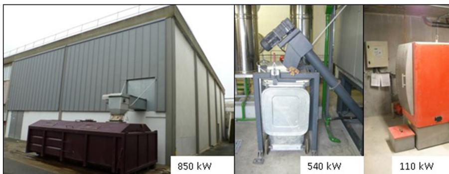
▲ Figure 22 : Bac à cendres sous foyer (de gauche à droite : 8 m<sup>3</sup>, 300 litres, 20 litres)
