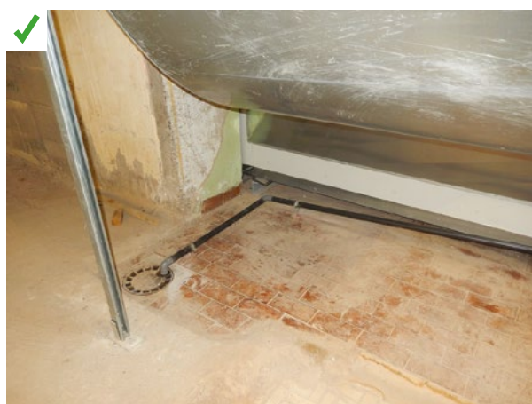
En l'absence de réseau d'évacuation des eaux usées proche, l'évacuation des condensats est raccordée sur le réseau d'évacuation des eaux pluviales. ©AQC
