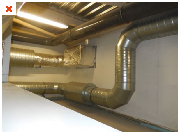
Dans cette installation, l'ouverture du caisson est orientée vers l'extérieur. Le changement du préfiltre est réalisable uniquement par une nacelle depuis l'extérieur. Ce surcoût peut décourager le MOA. ©AQC
