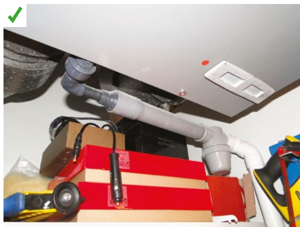
L'évacuation des condensats a été raccordée au réseau d'eaux usées du bâtiment. ©AQC
