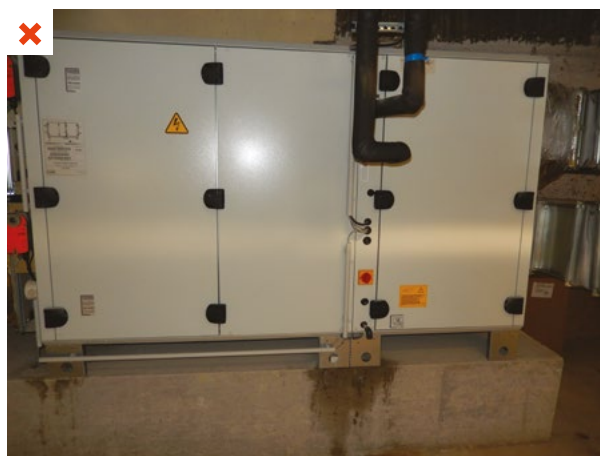
Sur cette CTA, l'évacuation des condensats n'a pas été raccordée au réseau EU ou EP, ce qui engendre de l'humidité sous la CTA. ©AQC
