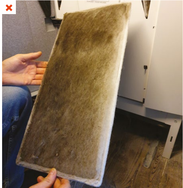
Le filtre présente un encrassement important, car il n'a pas été changé dans le délai impartit. ©AQC
